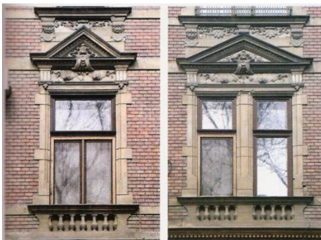
Slika 5.1.5. Ornamentalni elementi fasade, Najamna palata Ignaca Kuneca - Petra Drapšina 2, izvor: knjiga Gradotvorci II, str. 227.
