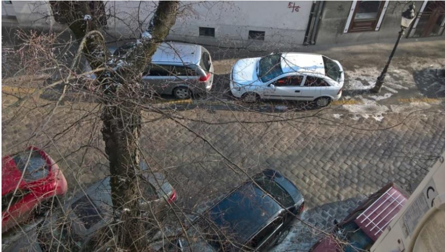
Slika 4.1.2. Pogled sa prozora zgrade br. 4 na dotrajalu kaldrmisani put na ulici, izvor: Fotografija autora, januar 2017.
